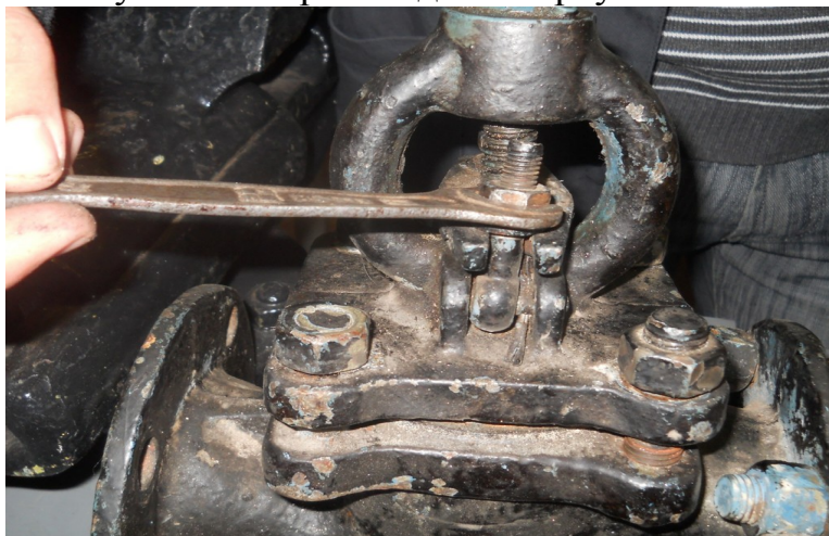
Рисунок 11- Производим сборку сальника.
