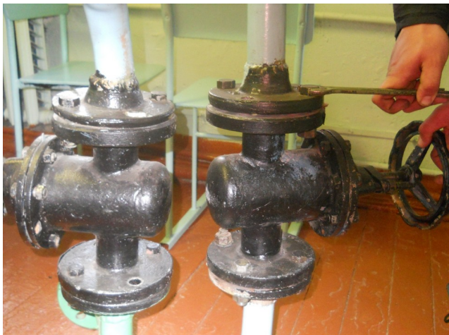
Рисунок 3- Отвинчиваем гайки нажимной втулки.
